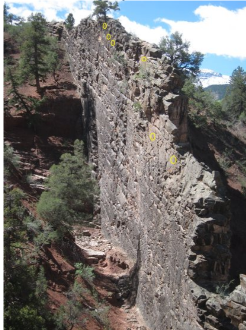
Dike Wall - Ridgway
